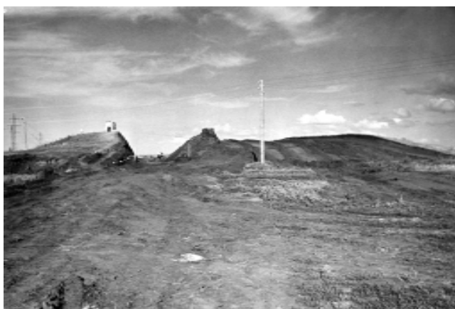
Фото 3. Царев курган. Траншея через насыпь и снятие насыпи скрепером. 1959 год.
